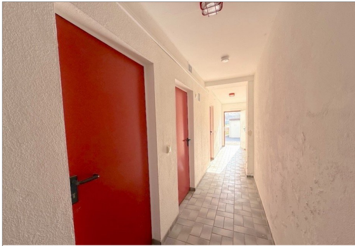
Zugang vom KG Bild 1
